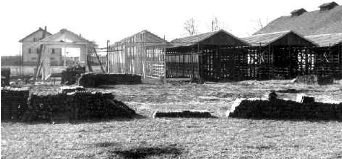
Neubau von Trockenstadeln, Mitte 20. Jahrhundert
